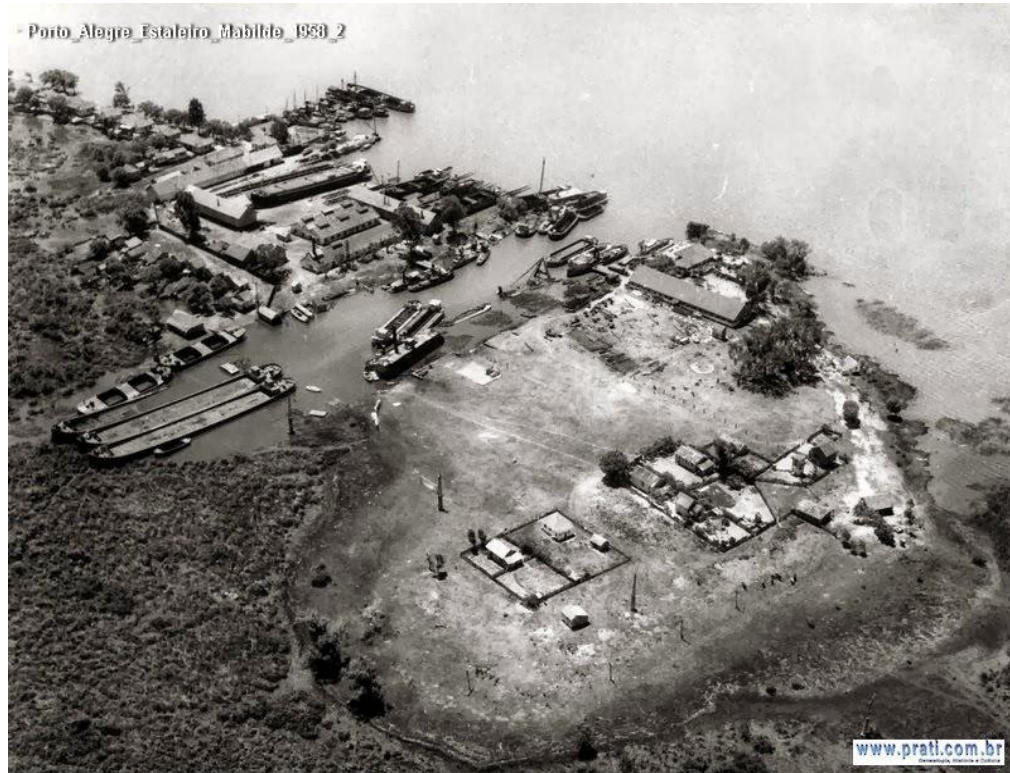
Fotografia 3 – Imagem aérea do Estaleiro Mabilde (1958)
