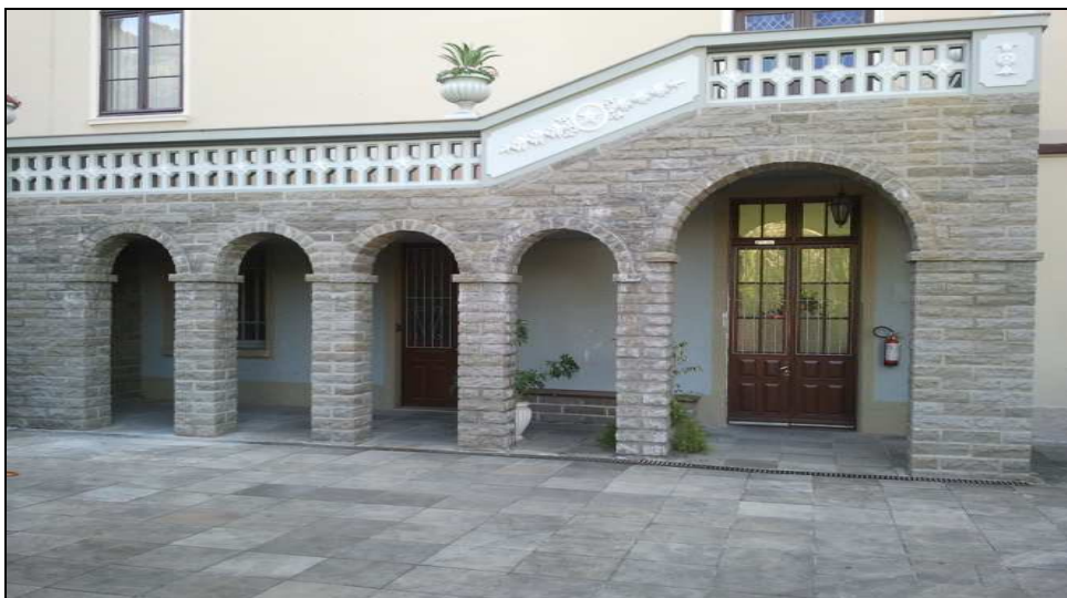
Figura 7 – Piso com laje regular e estrutura em arcos e fachada com pedras de muro
