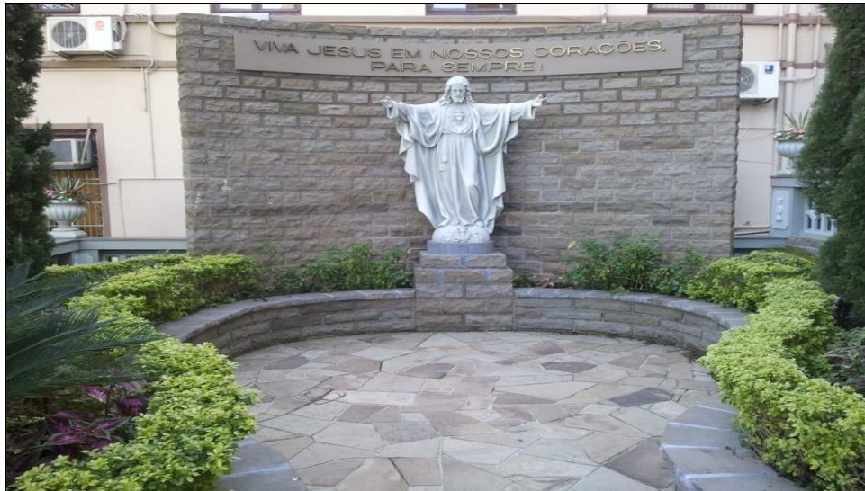
Figura 8 – Parede Decorativa: piso com pedra irregular e pedra de muro
