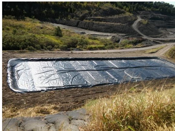
Figura 2 - Preparação do aterro sanitário CRVR.
