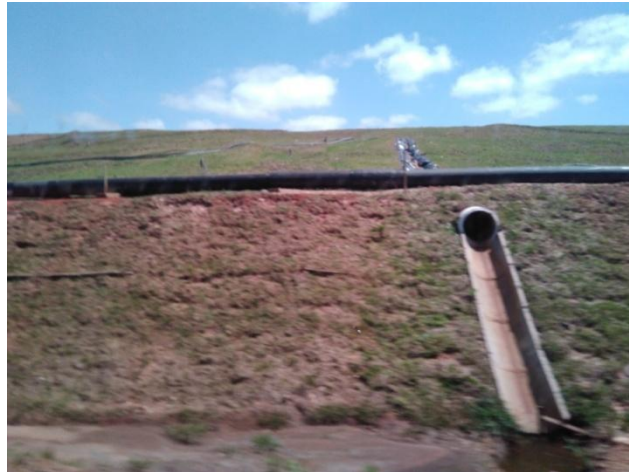
Figura 4 - Drenos d'água.
