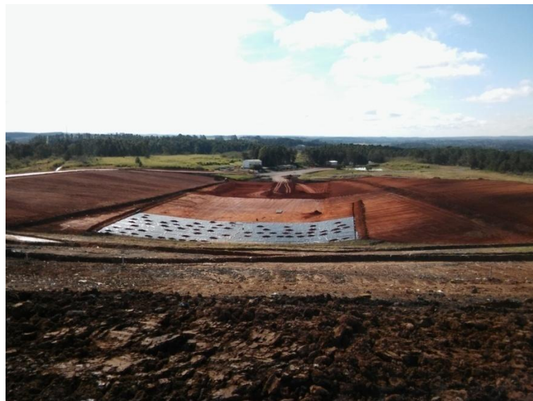
Figura 19 - Aterro sanitário da CRVR, no Municípios de Minas do Leão.
