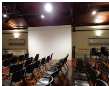
Figura 25 - Detalhe da adequação dos condicionadores de ar
