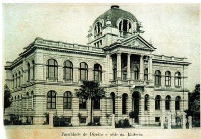
Figura 41 - Fachada da Faculdade de Direito em 1938
