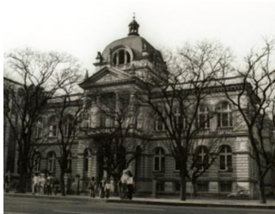
Figura 42 - Fachada da Faculdade de Direito em 1979
