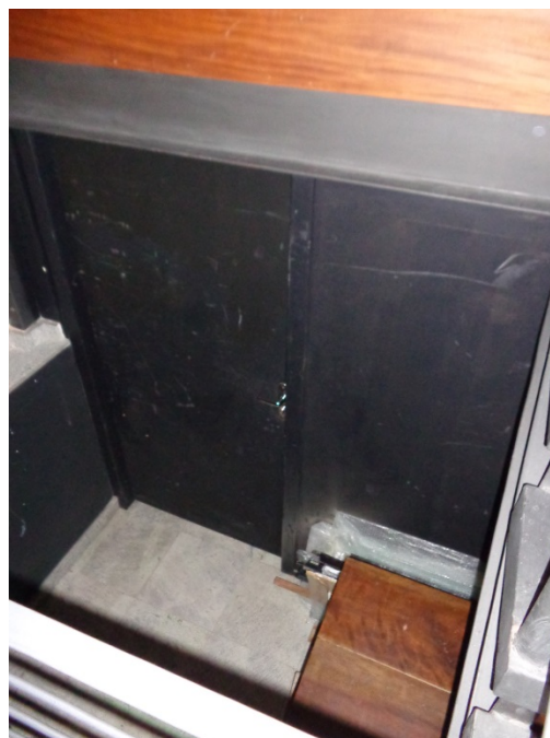
Figura 32 - Porta de entrada para o depósito de materiais
