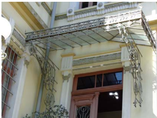
Figura 24 - Cobertura do patamar da escada da entrada principal
