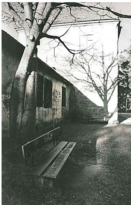
Figura 5 - Fachada lateral do prédio interditado entre 1996 e 1999
