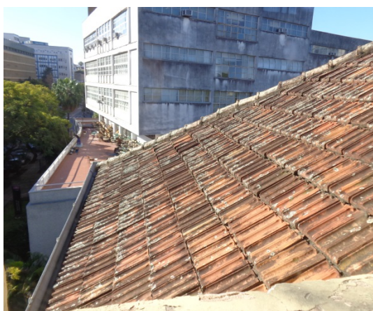
Figura 32 - Cobertura do Telhado
