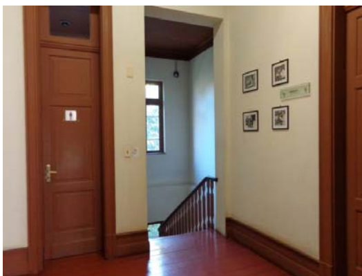
Figura 17 - Piso de madeira do saguão do segundo pavimento
