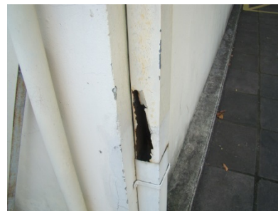
Figura 35 - Exemplo de calha com buraco
