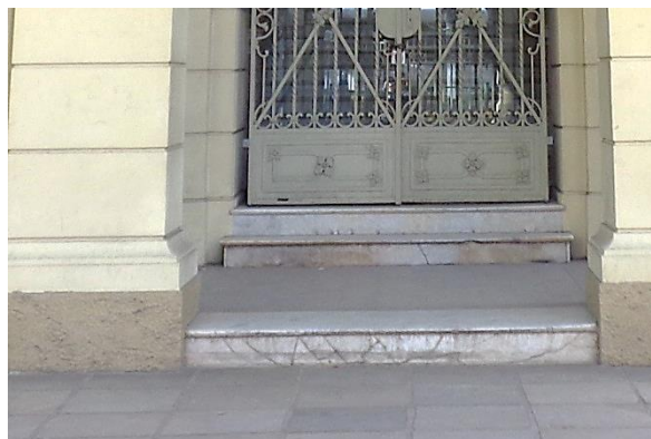
Figura 37 - Degraus da entrada principal
