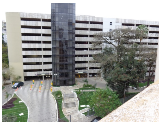
Figura 53 - Edifício de estacionamento da Santa Casa de Misericórdia de Porto Alegre visto do terraço do Observatório
