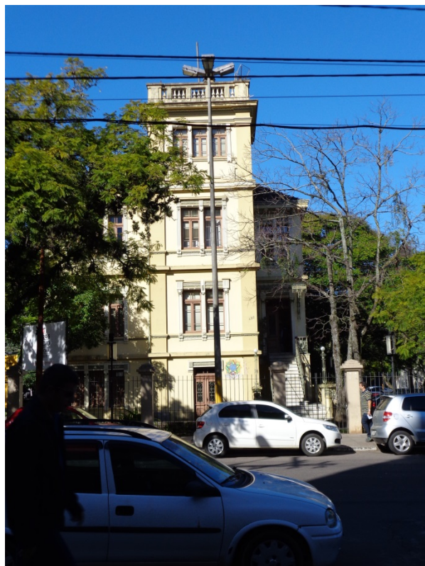
Figura 25 - Torre localizada na fachada frontal
