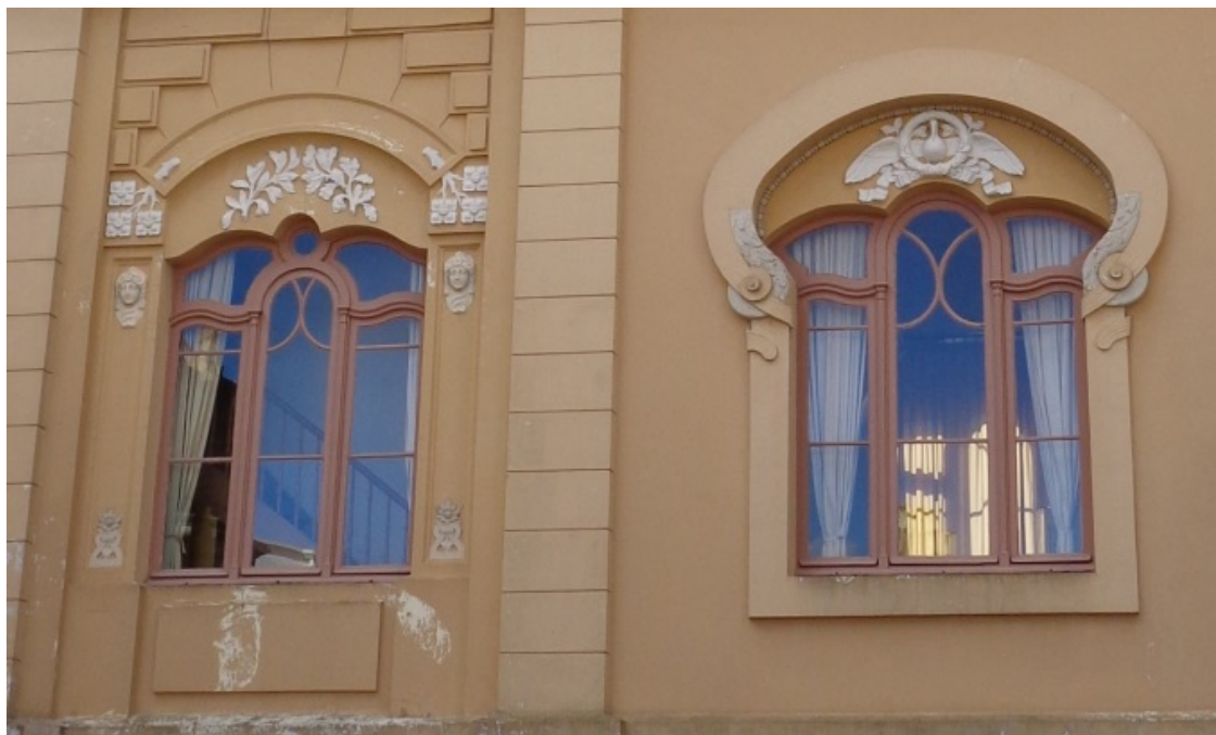
Figura 32 - Detalhes das janelas
