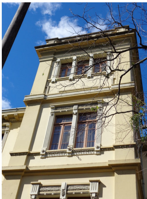
Figura 31 - Detalhes das Janelas
