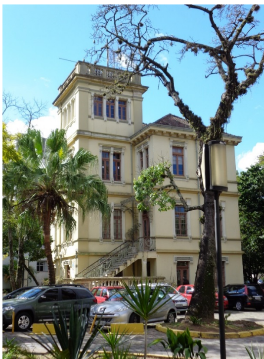
Figura 22 - Fachada lateral onde se vê o porão habitável
