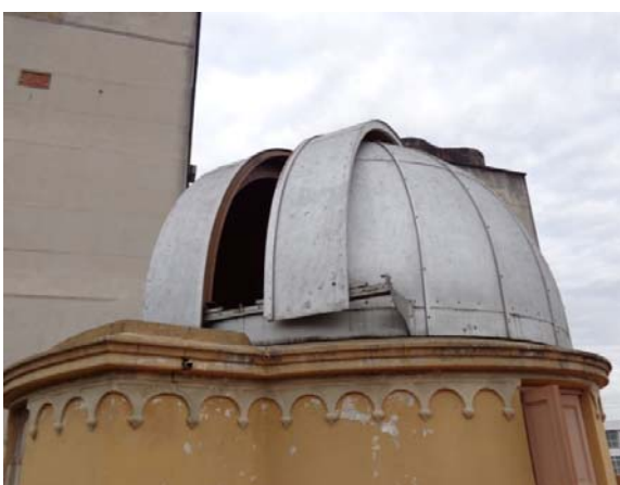
Figura 27 - Parte externa da cúpula toda em metal
