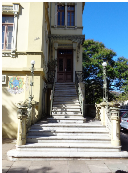
Figura 23 - Escadaria que dá acesso à entrada principal
