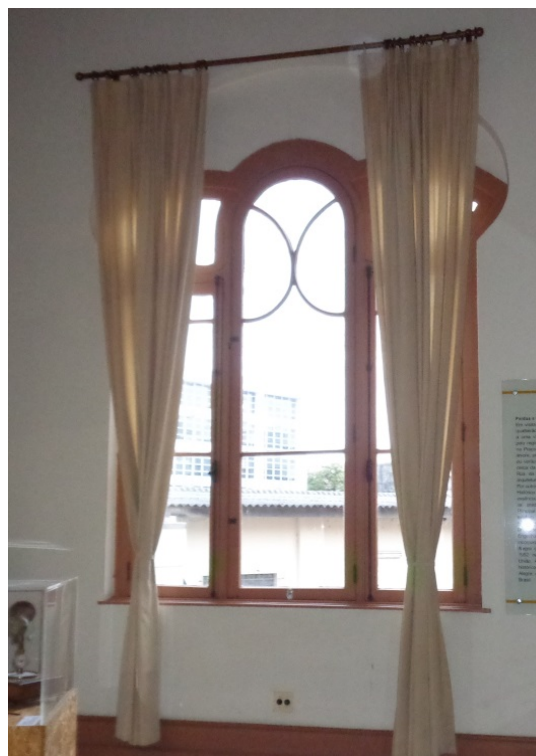
Figura 37 - Janela da sala no segundo pavimento
