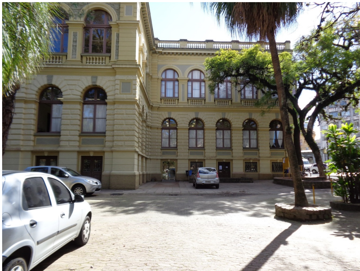
Figura 20 - Fachada lateral, com a porta de vidro, acesso atual ao prédio
