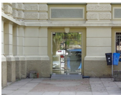
Figura 30 - Porta de vidro na entrada lateral
