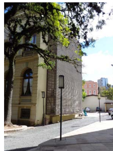
Figura 31 - Condicionadores de ar cobertos pela estrutura metálica vazada localizada na fachada posterior do prédio
