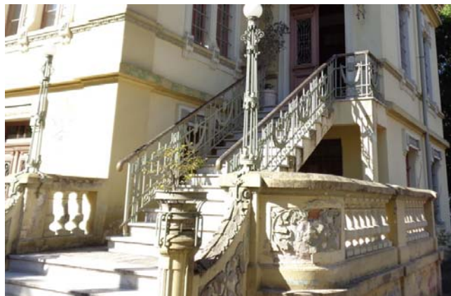
Figura 36 - Base da escada e parte da fachada lateral
