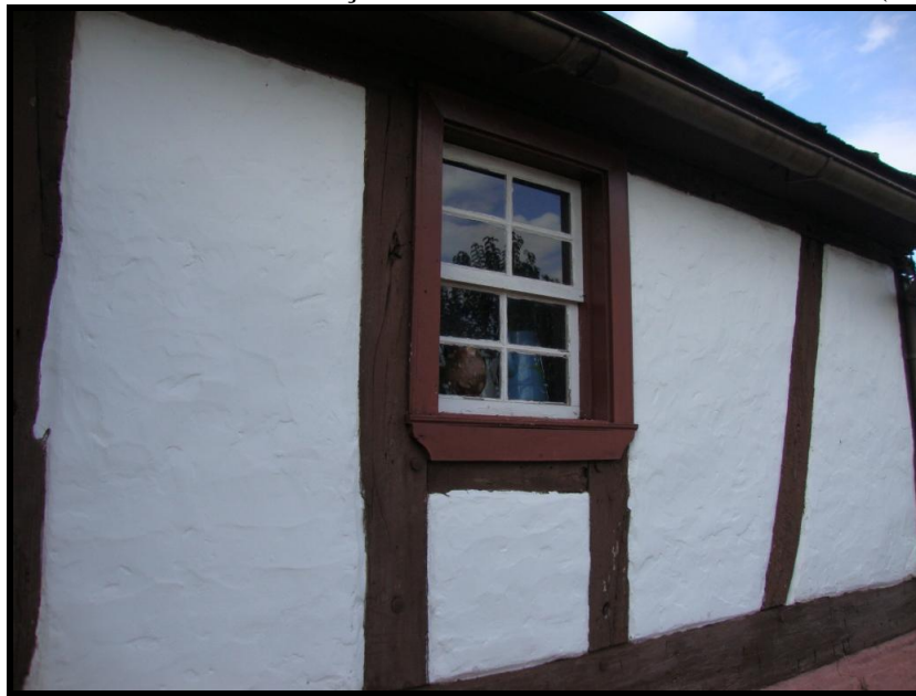
Figura 25 - Detalhes da construção enxaimel - fachada lateral direita (MHMDI).
