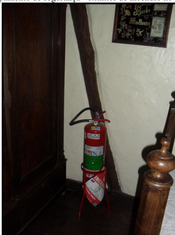
Figura 38 - Equipamento de segurança - extintor de incêndio no quarto (MHMDI).
