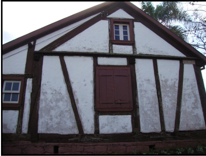
Figura 24 - Detalhes da construção enxaimel - fachada lateral esquerda (MHMDI).
