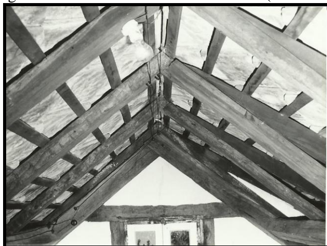
Figura 32 - Reforma do telhado do sótão (MHMDI).
