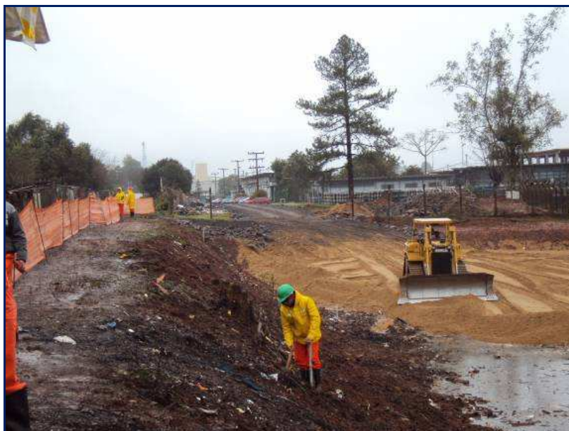
Foto 11 - Abertura de caminho de serviço/Terraplanagem, km 20+500, Interseção 5
