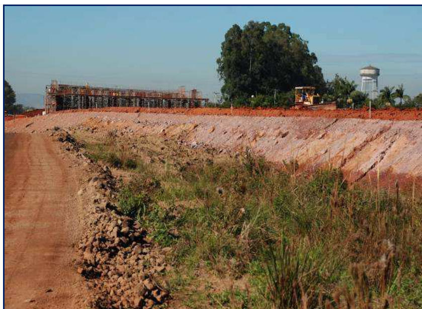
Foto 12 - Atividade de aterro, imprimindo aumento de cota ao relevo, km 13+200
