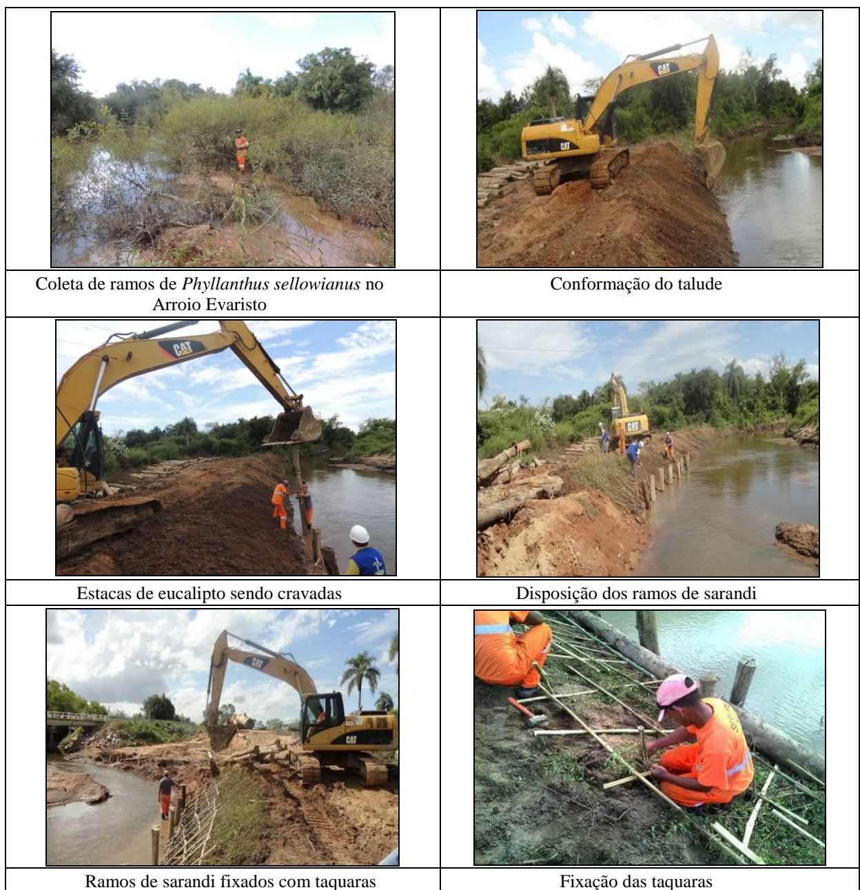
Figura 6 – Bioengenharia de solos no segmento da margem esquerda do Arroio Viúva Tereza
