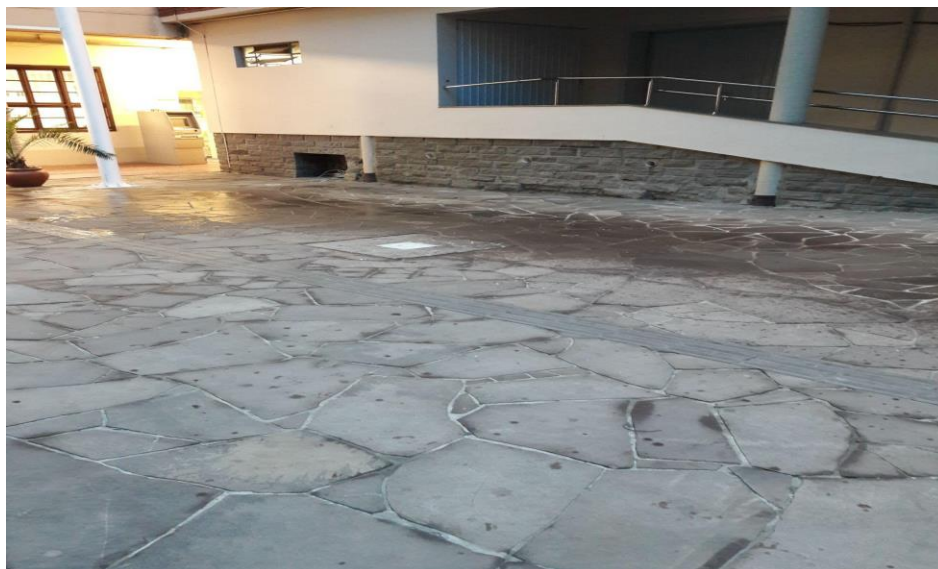
Figura 51 - Inserção do piso podotátil vinílico na área coberta lateral ao Salão de Atos, Prédio 8 e Prédio 10
