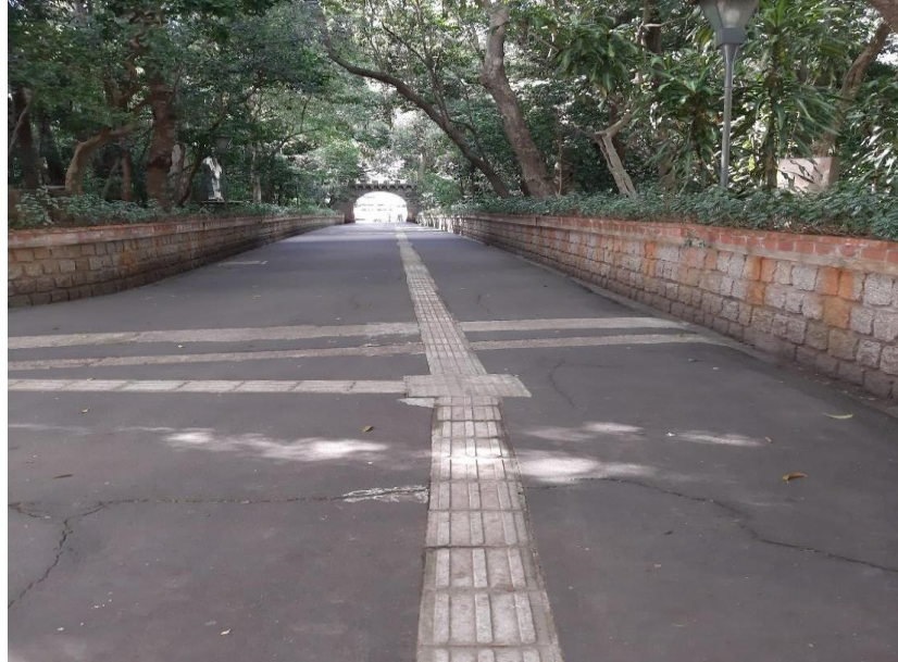
Figura 40 - Acesso ao Campus pelo “Túnel Verde”, com execução da inserção do piso podotátil cimentício para acessibilidade, na intersecção dos prédios 5, 6, 8 e Biblioteca
