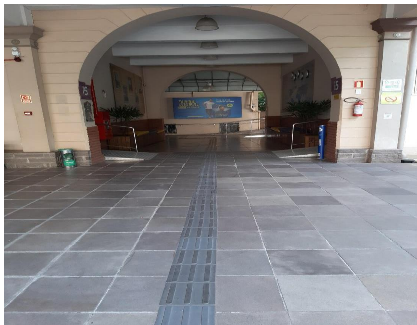
Figura 47 - Inserção do piso podotátil vinílico sobre revestimento de basalto no saguão e passadiço do prédio 5 da Universidade La Salle – Prédio Centenário de Interesse Cultural
