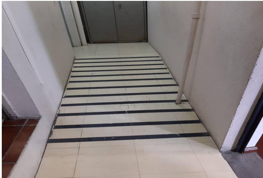
Figura 27 - Rampa de acesso ao Laboratório de Informática em piso vinílico e faixas adesivas antiderrapantes
