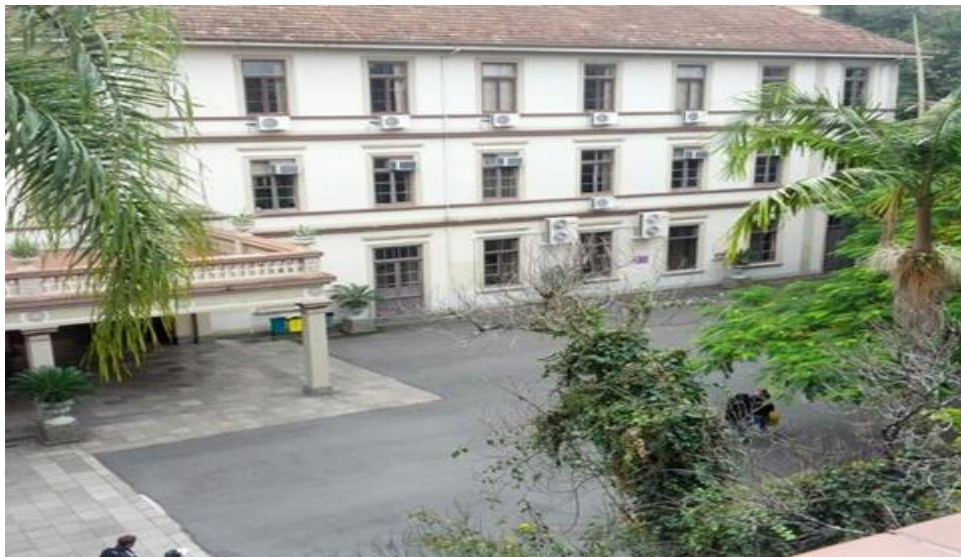
Figura 41 - Prédio 5 – Primeiro Prédio do Campus, construído em 1910, antes da inserção de piso podotátil nas áreas externa e interna da edificação
