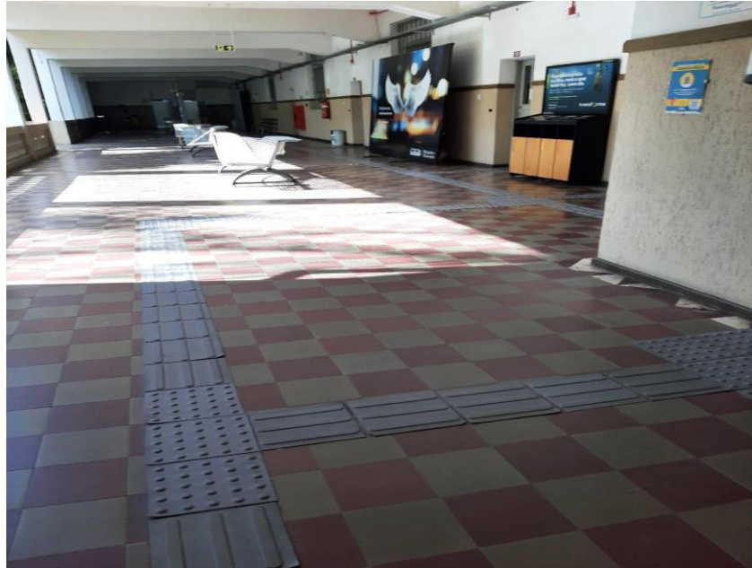
Figura 48 - Inserção do piso podotátil vinílico sobre ladrilho hidráulico no saguão do prédio 8 da Universidade La Salle – Prédio Centenário de Interesse Cultural
