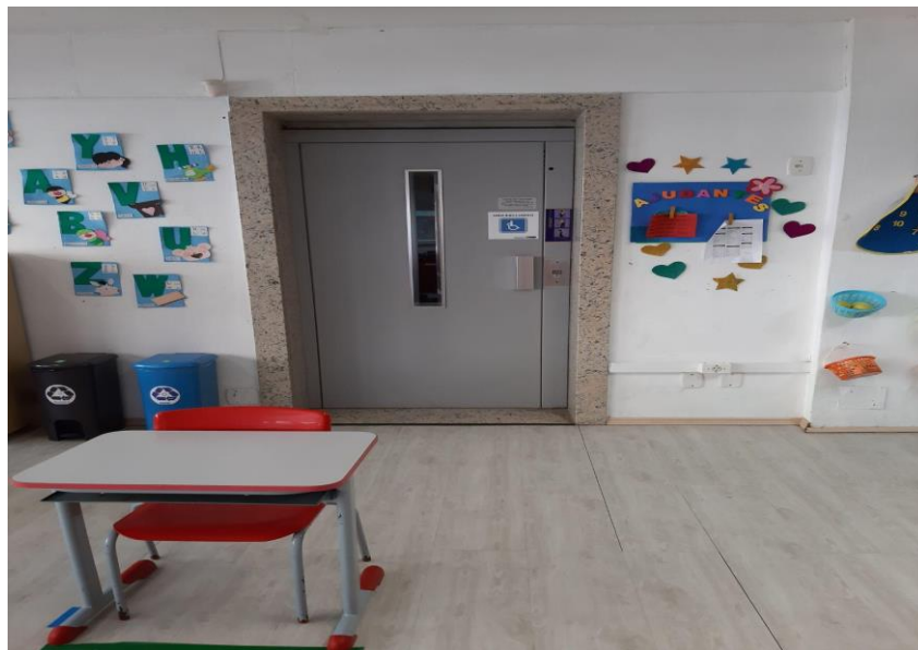
Figura 21 - Instalação de elevador para acessibilidade no deslocamento às salas de aula do 1º andar
