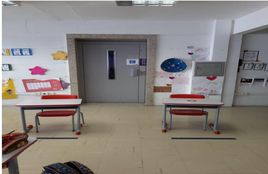
Figura 22 - Instalação de elevador para acessibilidade no deslocamento às salas de aula do 2º andar
