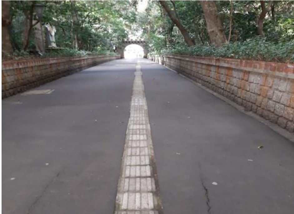
Figura 38 - Acesso ao Campus pelo “Túnel Verde”, com execução da inserção do piso podotátil cimentício para acessibilidade
