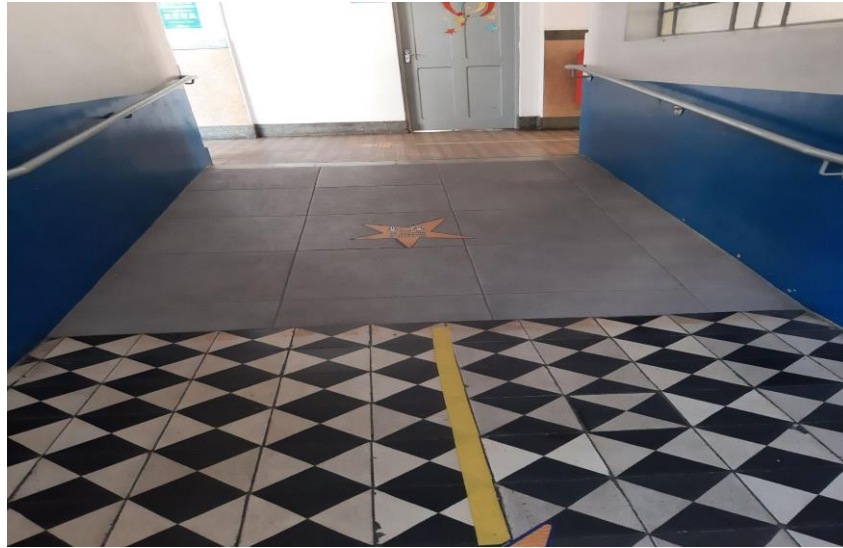
Figura 26 - Rampa de acesso na circulação com corrimãos de apoio
