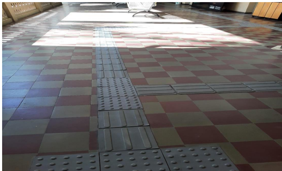
Figura 43 - Inserção do piso podotátil vinílico sobre ladrilho hidráulico na circulação do Prédio 4 da Universidade La Salle – Prédio Centenário de Interesse Cultural
