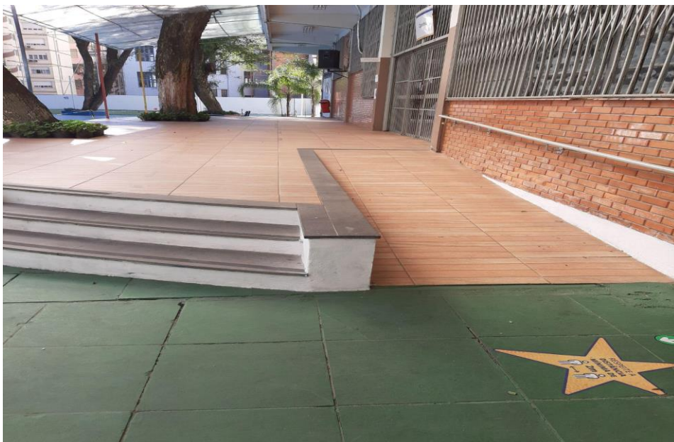
Figura 19 - Rampa de acesso do pátio principal para a cantina em piso antiderrapante
