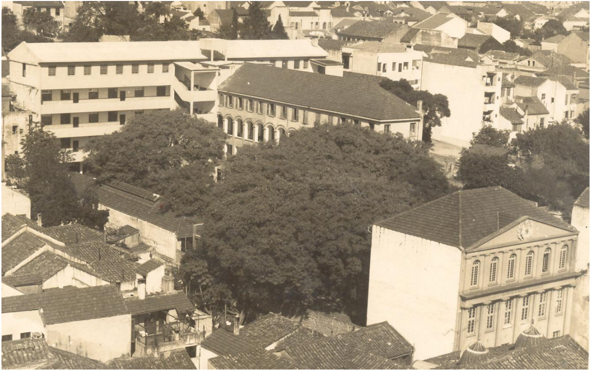
Figura 4 - Vista aérea da fachada posterior Colégio La Salle Dores
