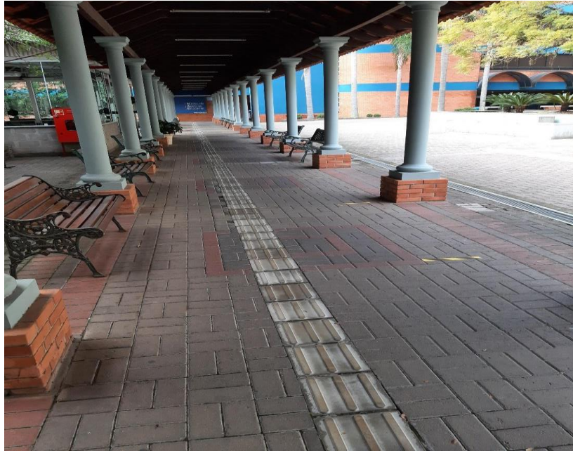
Figura 50 - Inserção do piso podotátil cimentício em bloco cimentício intertravado na passarela de ligação entre os prédios do Campus da Universidade La Salle
