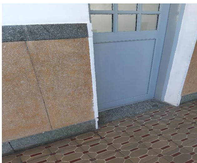
Figura 16 - Circulação com revestimento em granitina nas paredes e ladrilho hidráulico no piso
