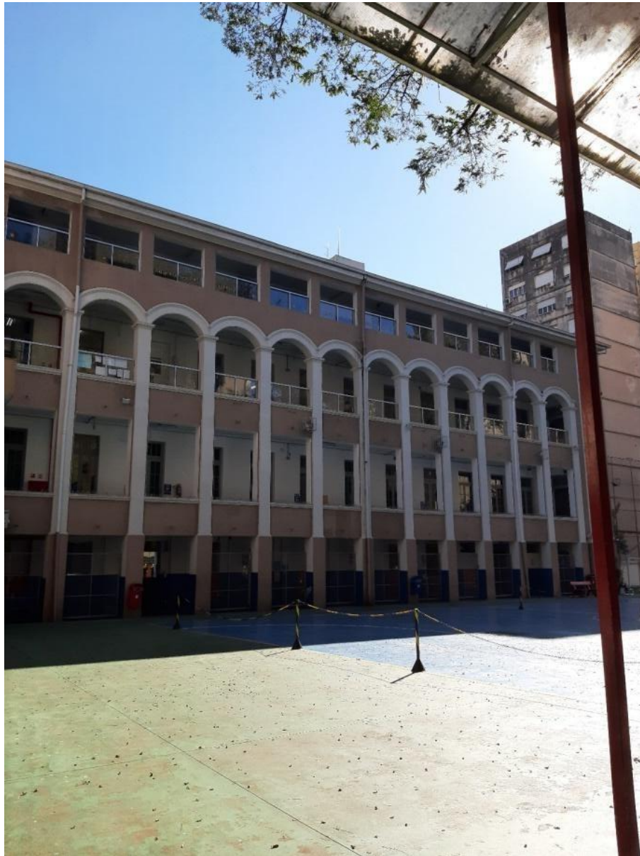
Figura 5 - Vista da fachada interna do Colégio La Salle Dores, construída em 1940 e revitalizada na década de 2010
