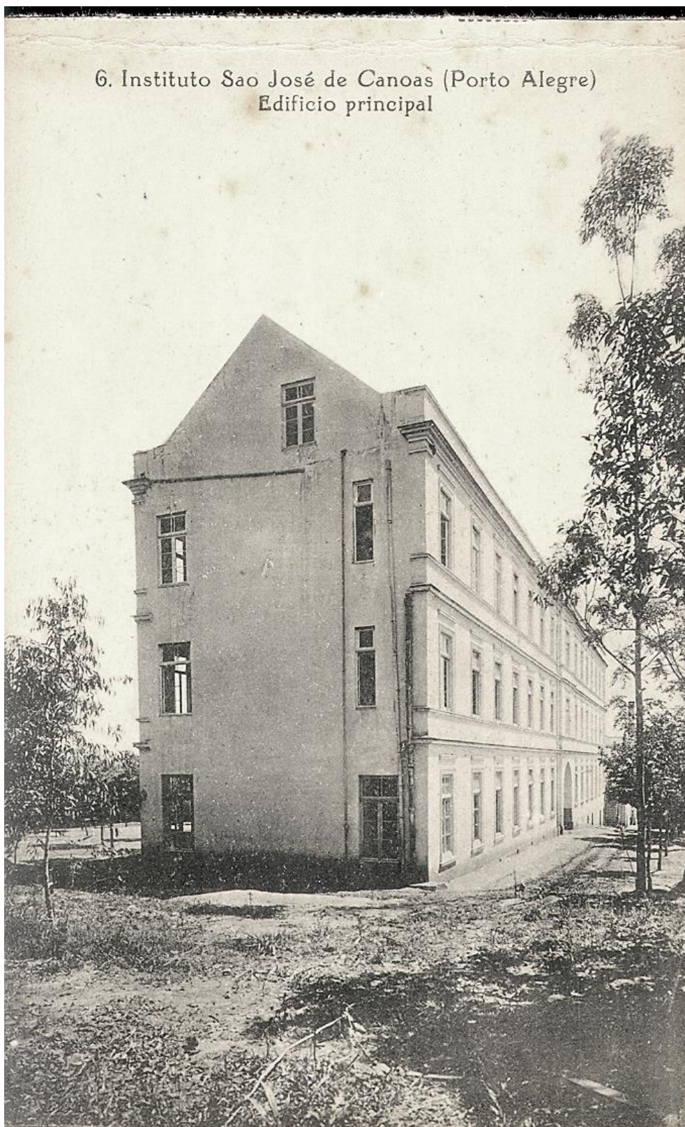
Figura 8 - Primeiro prédio do Instituto São José (Década de 1910) Atual Prédio 5 da Universidade La Salle
