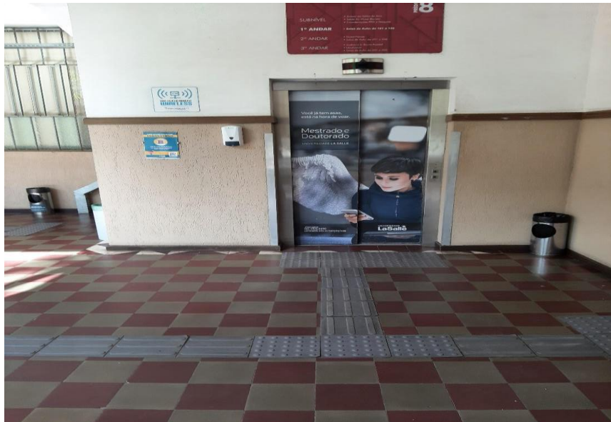
Figura 46 - Inserção do piso podotátil vinílico sobre ladrilho hidráulico no saguão do prédio 8 da Universidade La Salle – Inserção de elevador - Prédio Centenário de Interesse Cultural
