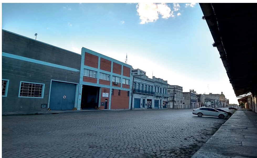
Figura 1 - Rua Riachuelo, proximidades com a Travessa do Afonso. À esquerda, em primeiro plano, dois imóveis da empresa Sampayo Nickhorn. Na sequência (esquina), a sede da Wilson Sons S.A. À direita, a estrutura do Porto Velho.
