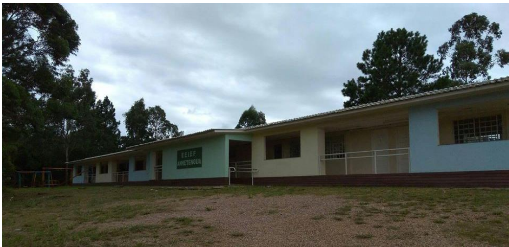
Figura 12 – Estrutura provisória construída para abrigar a escola.
