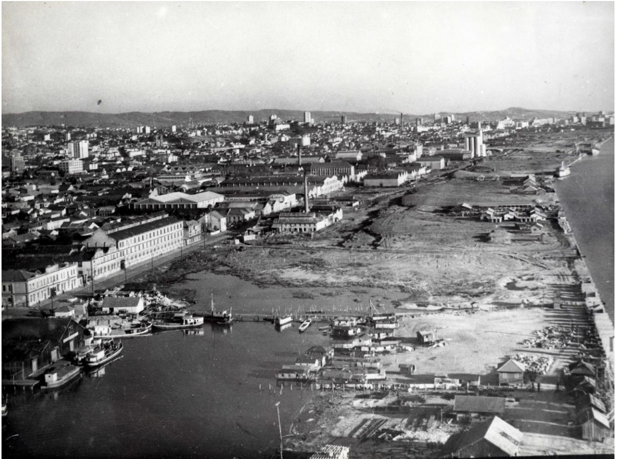
Figura 7 – Aterro na rua Voluntários da Pátria em 1955
