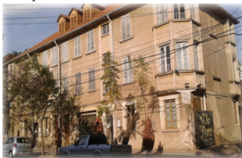
Figura 1. Centro Cultural Vila Flores, vista do prédio na lateral
