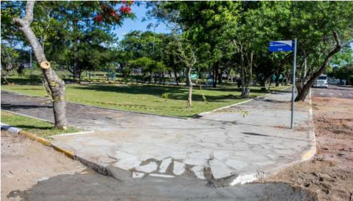
Figura 5 – Vista da Rua das Castanhairas, Bairro Igara, Canoas, RS (2018)
