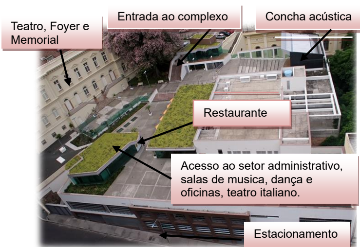
Figura 5: Vista aérea do Teatro e Multipalco
