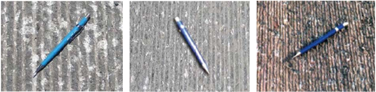
Figura 7 - Fresagem padrão, fresagem fina e microfresagem
