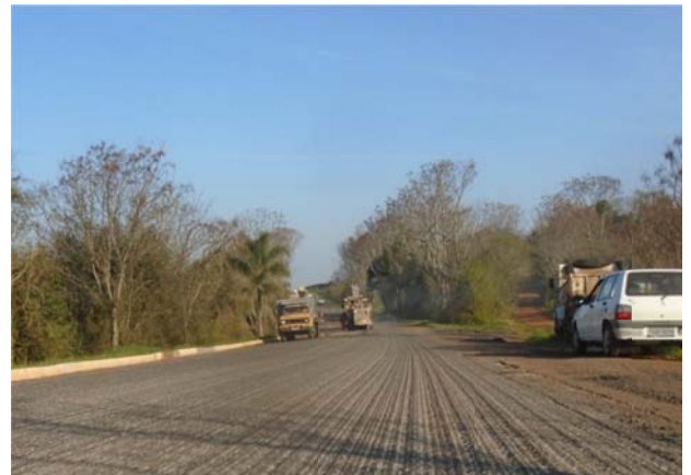
Figura 15 - Coleta do material fresado
