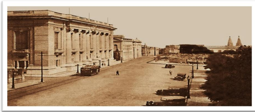
Fig. 17 - Demolição do Prédio da Companhia Hidráulica Porto-Alegrense. Porto Alegre (RS). [ca. 1928].
