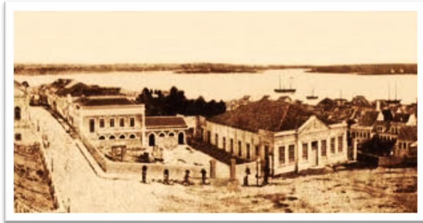
Fig. 5 - Prédio da Companhia Hidráulica Porto-Alegrense. Porto Alegre. [ca 1866].
