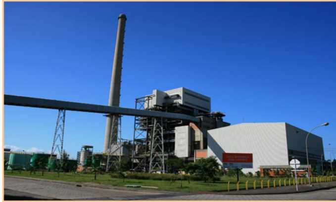
Figura 14 - UTLC (unidade 7) – 363 MW
