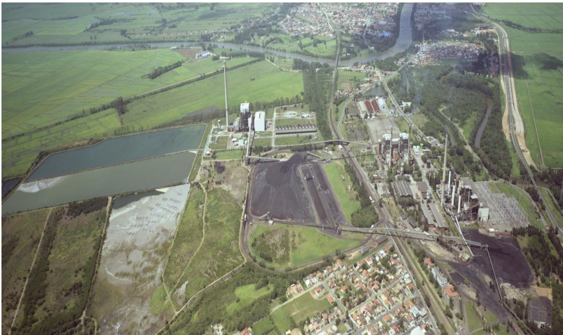
Figura 11 – Vista geral do Complexo Termelétrico Jorge Lacerda
