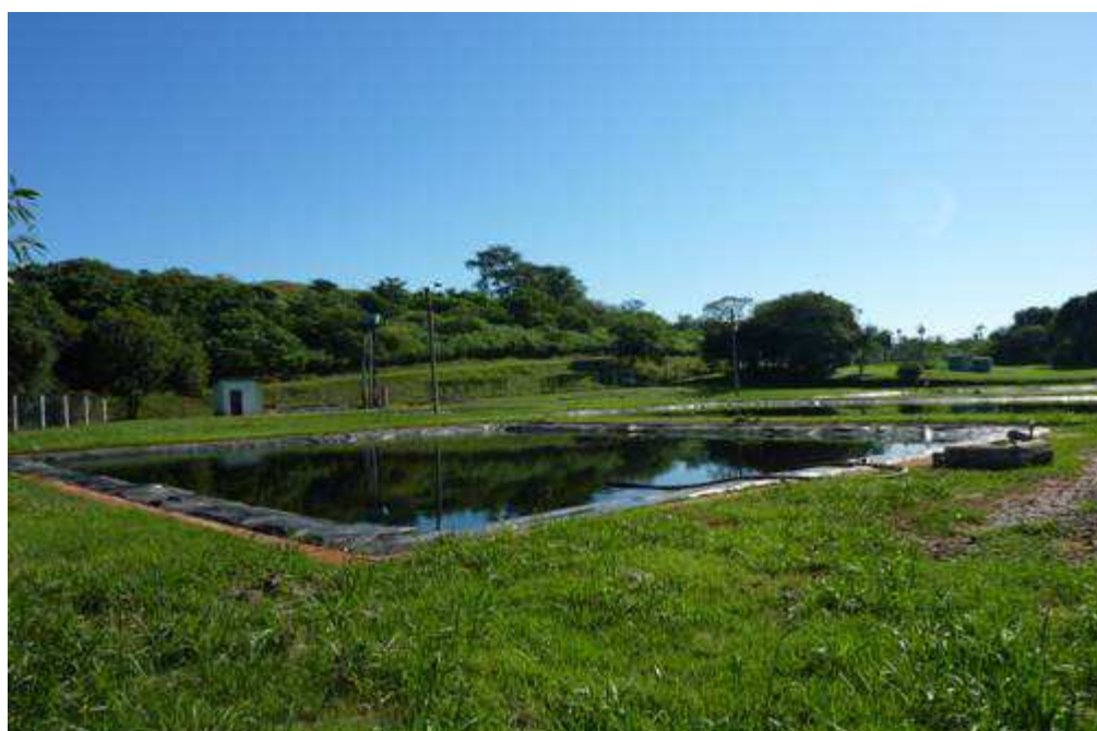
Figura 5 - Lagoas de estabilização do aterro Sanitário Guajuviras
