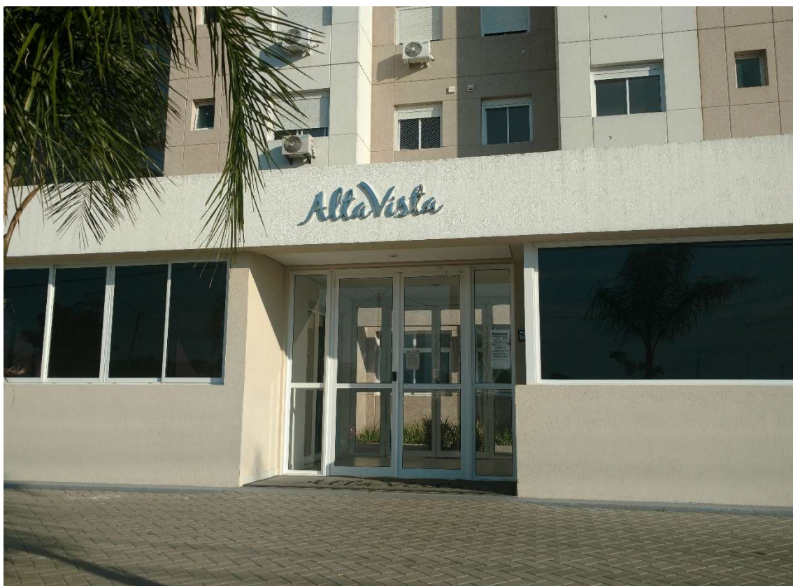
Figura – fotografia de elemento de fechamento (espaço IV)
