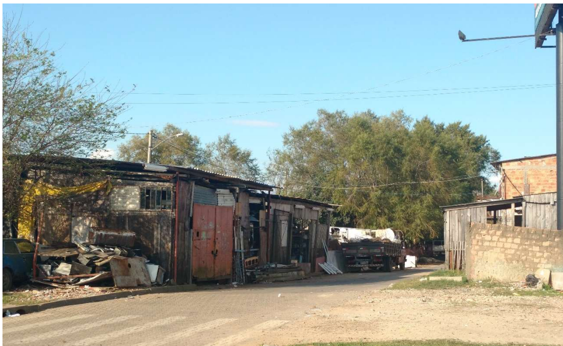
Figura 28 – fotografia de elementos de fechamento – Vila Farrapos (espaço III) (c) Fonte: AUTOR
