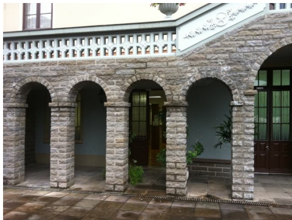
Figura 05: Foto do Prédio do Laboratório(Nº2) 24 horas.
