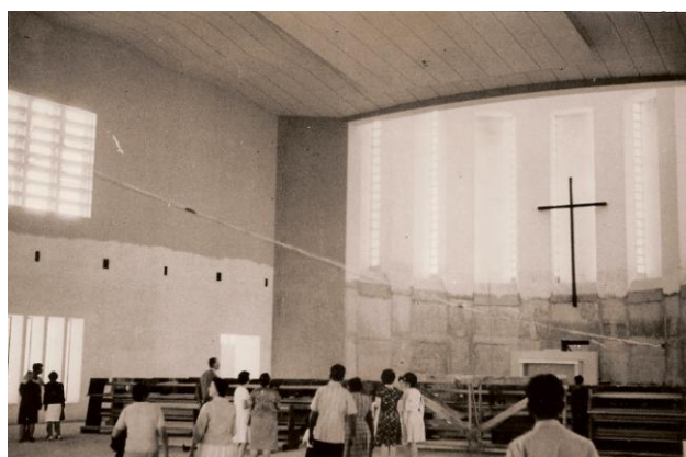
Figura 48 – Ambiente interno da igreja sem os andaimes, em 1963.
