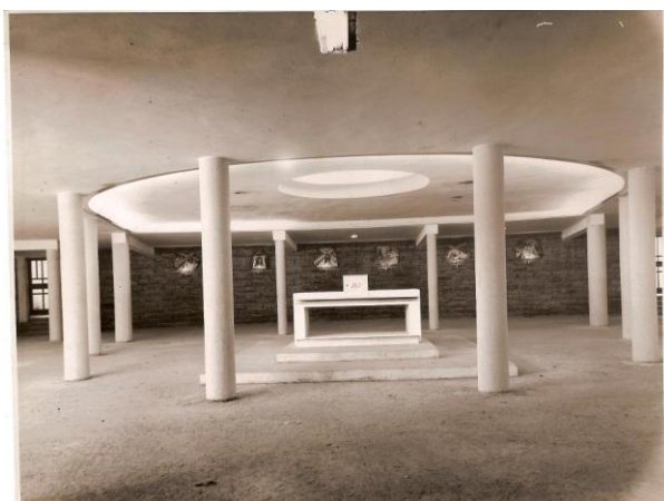
Figura 47 – Cripta da igreja parcialmente finalizada com a via-sacra em mosaico, ao fundo, na parede, no ano de 1963.
