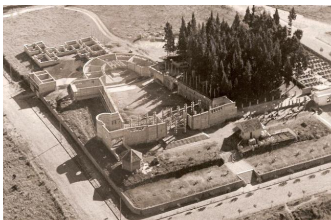
Figura 46 – Vista aérea da igreja em construção na década de 1960. Fonte: Acervo fotográfico da Livraria Editora Padre Reus, autor não indicado.
