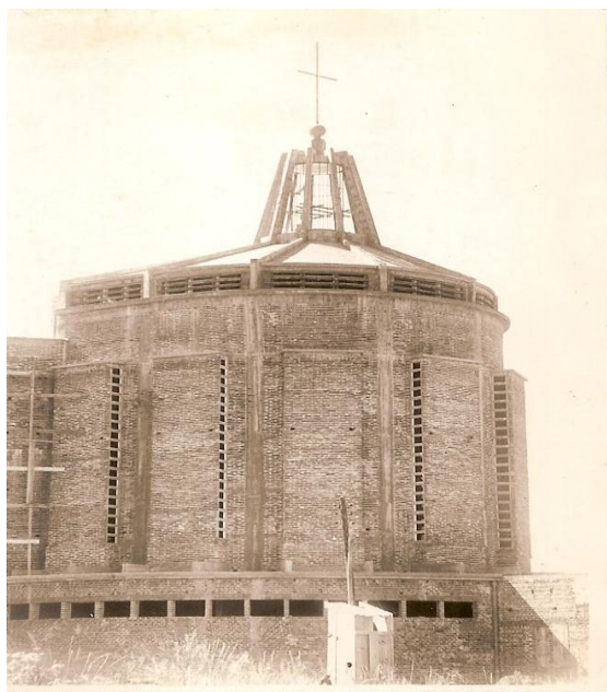
Figura 53 – Vista externa do presbitério em construção, na década de 1960.
