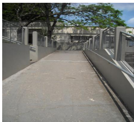
Figura 77 – Rampa de acesso ao túmulo.
