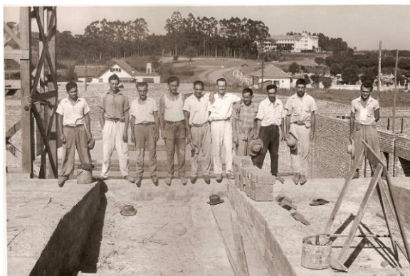
Figura 39 – Operários que construíram a igreja durante dez anos. Fonte: Acervo fotográfico da Livraria Editora Padre Reus, autor não indicado.
