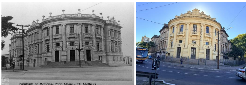
Figura 11 – Antigo Prédio da Faculdade de Medicina (prédio 12101)
