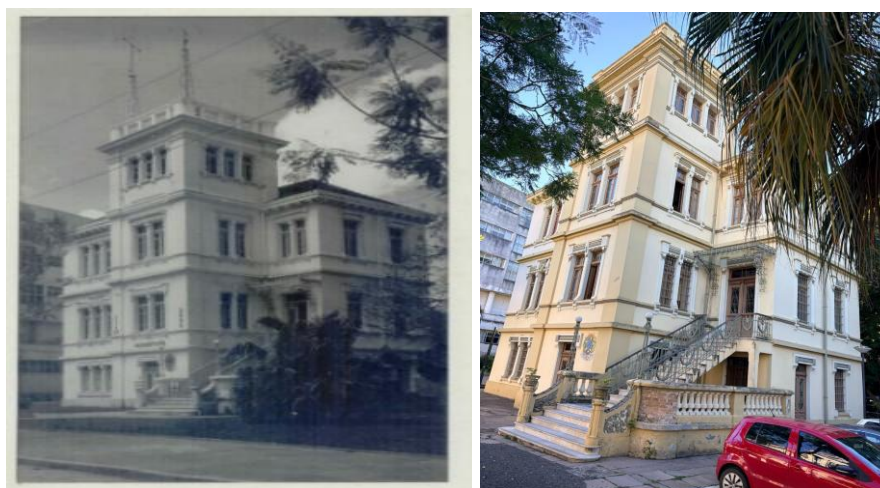
Figura 12 – Rádio da UFRGS (prédio 12102)
