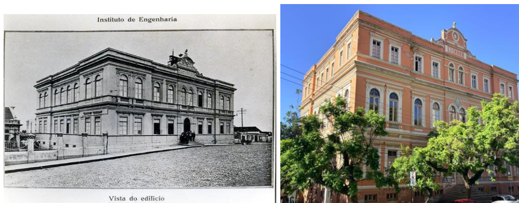
Figura 3 – Escola de Engenharia (prédio 11101)
