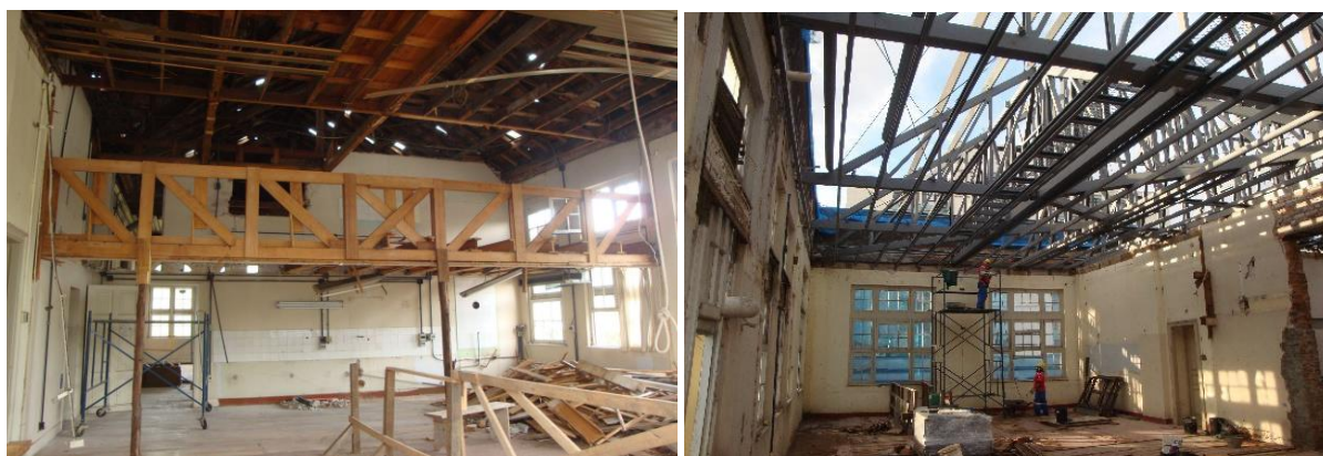
Figura 25 – Alterações não originais da edificação (esq.), alterações desfeitas (dir.)
