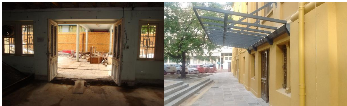
Figura 24 – Primeiro pavimento mais baixo do que o entorno (esq.) e desnível alterado (dir.)
