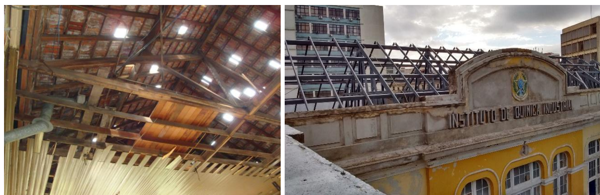
Figura 26 – Telhamento com estrutura de madeira (esq.) substituído por estrutura metálica (dir.)
