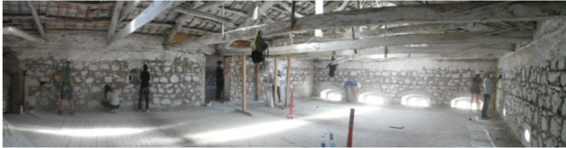
Figura 8: Raspado de los muros de carga.
