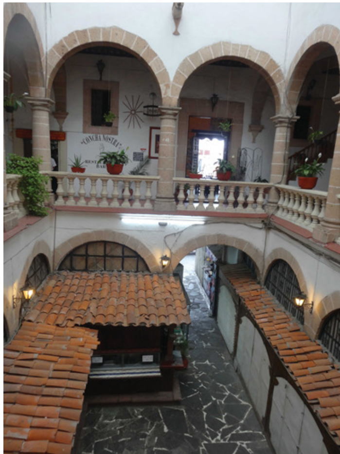
Figura 8. Sobre posición de locales comerciales en el patio central del edificio del hotel Casa Grande.
