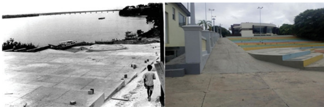
Figura 5: Rampa, escadaria e anfiteatro. Acervo da Divisão de Patrimônio Cultural de Roraima/Acervo de Jefferson Morales.
