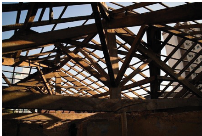
Figura 4 – Tesoura e trama do telhado
