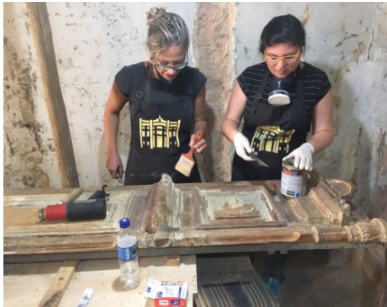
Figura 7 – Atelier de restauro das esquadrias.
