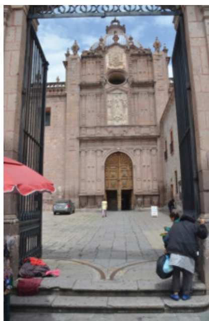
Figura 10. Acceso oriente al atrio de la Catedral. Desde el acceso al atrio los discapacitados tienen problemas de para acceder. Foto: LTG.
