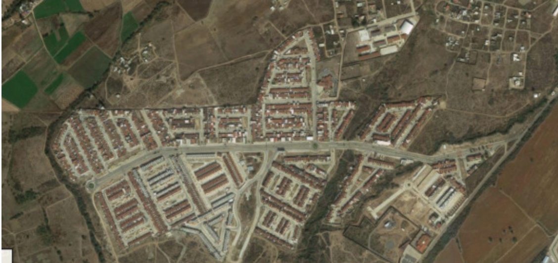
Figura 4. Vista aérea del fraccionamiento Villas de Guanajuato, conjunto de clústeres articulado por un boulevard que corre de oeste a este; mientras que el arroyo corre de norte a sur aproximadamente.
