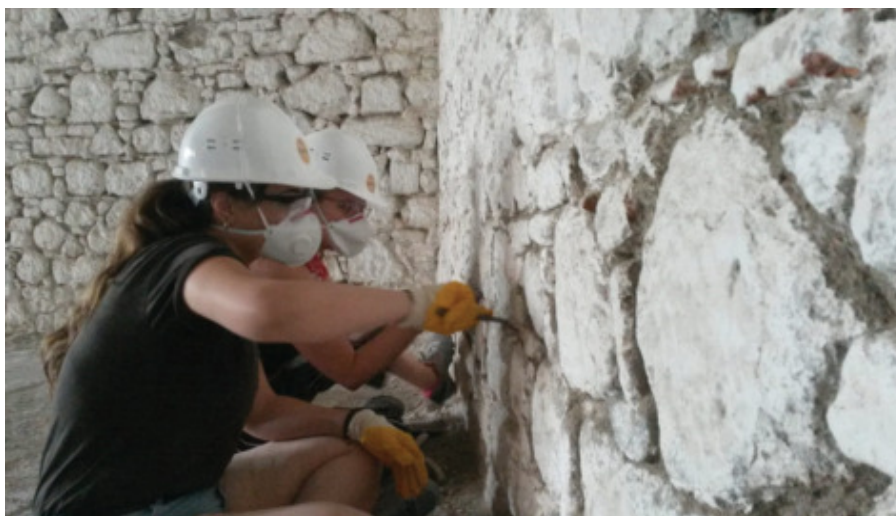
Figura 9: Detalle del raspado de los muros de carga. Fotografía de Jose Manuel García Torres. (Pérgamo. 2018). Archivo del autor, Estambul (Turquía)
