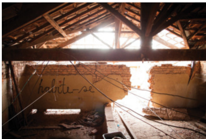
Figura 5 – Laje antes de sua demolição
