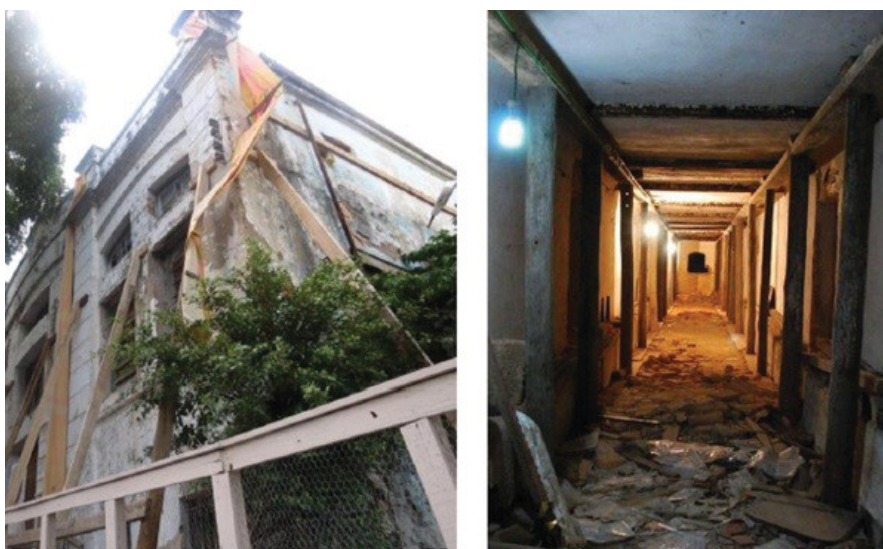
Figura 2 – Escoramento externo e interno do casarão. Fonte: Dossiê do Prêmio Rodrigo Melo Franco, IPHAN (2017)
