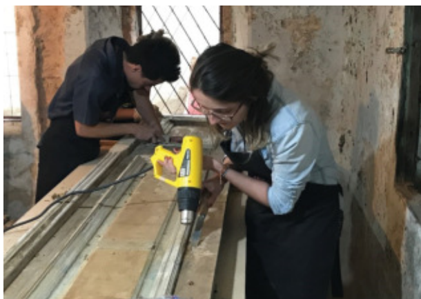
Figura 9 – Remoção da repintura com soprador térmico.
